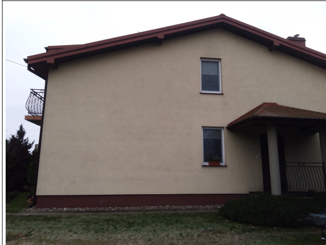
Elewacja północno-zachodnia, lokal „A” wejście do lokalu
