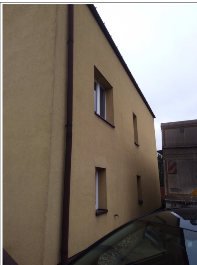
ściana zewnętrzna lokalu „B“ Widok od strony południowo-wschodniej
