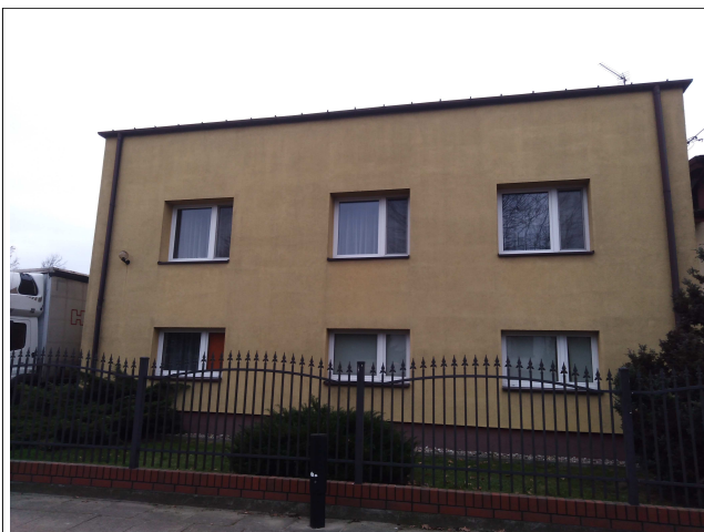
Widok od str. ulicy Matejki (północny wschód) ściana zewnętrzna lokalu „B“
